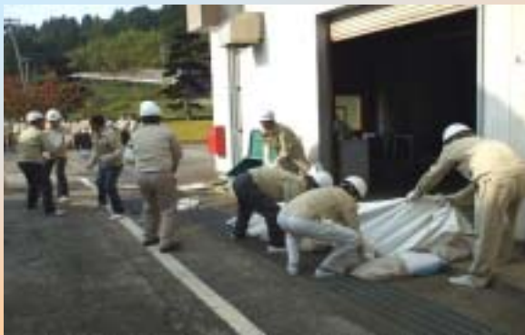
土嚢積みによる流出拡大阻止
