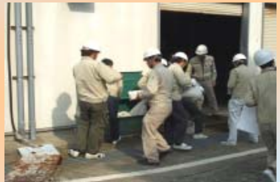
土嚢積みによる流出拡大阻止
